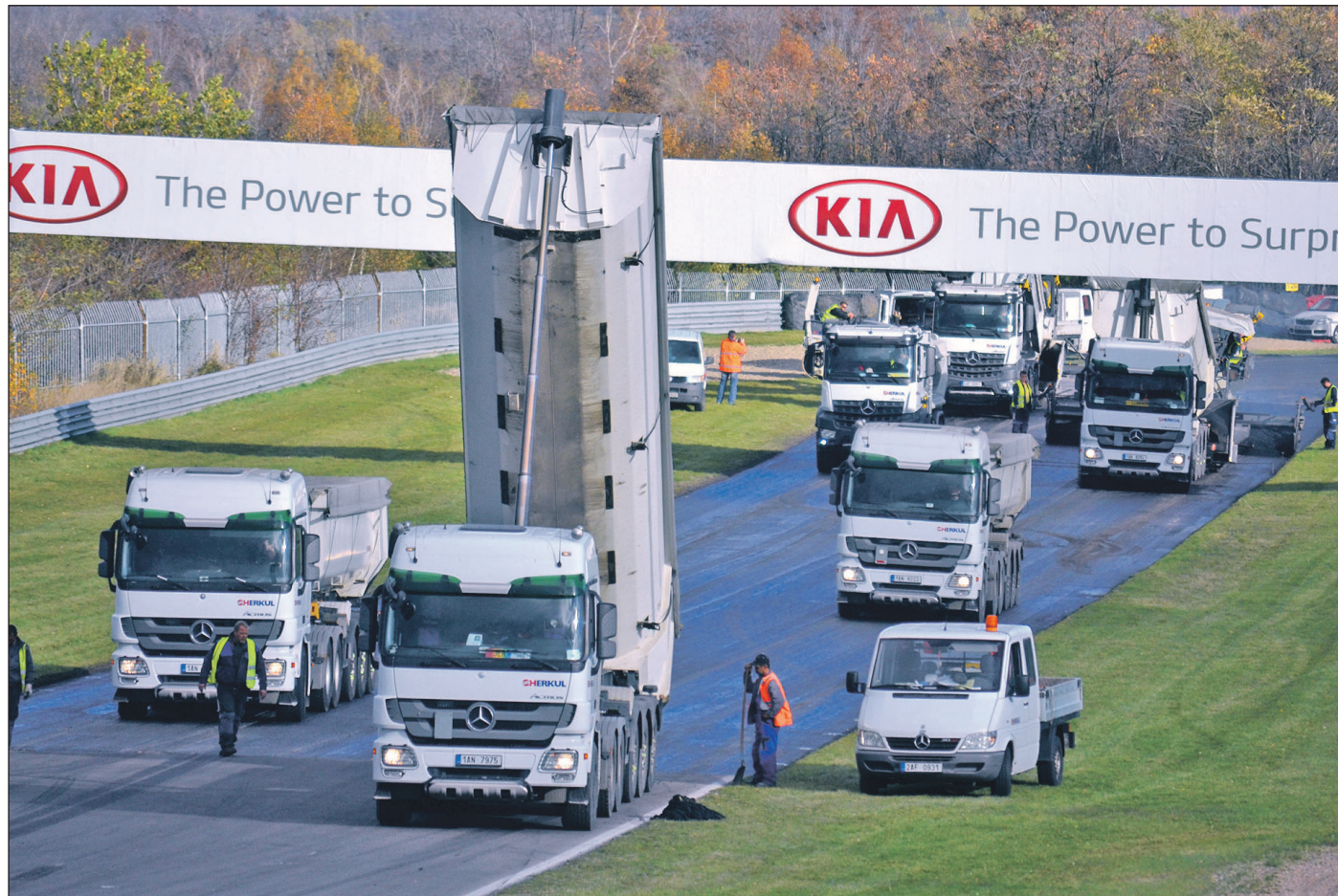
Výměna asfaltu a vybudování odvodnění bude provedeno na 630 metrech závodního okruhu.
